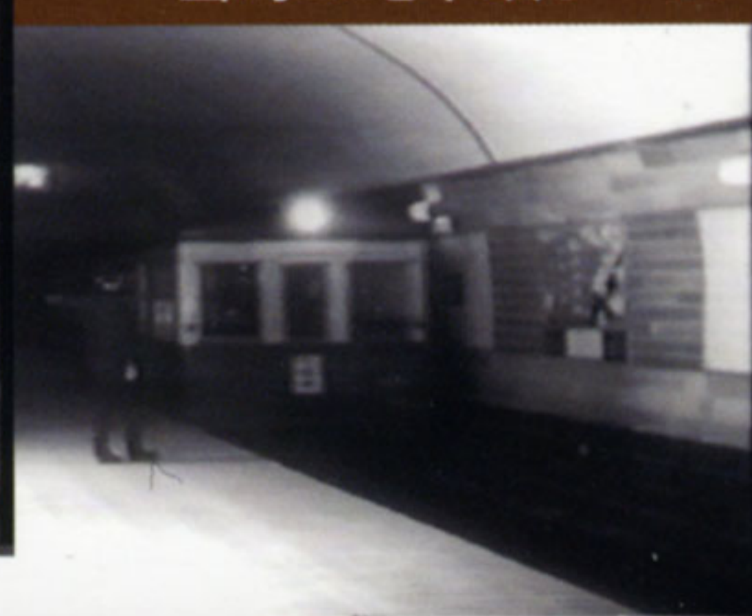
当時の地下鉄ホーム
